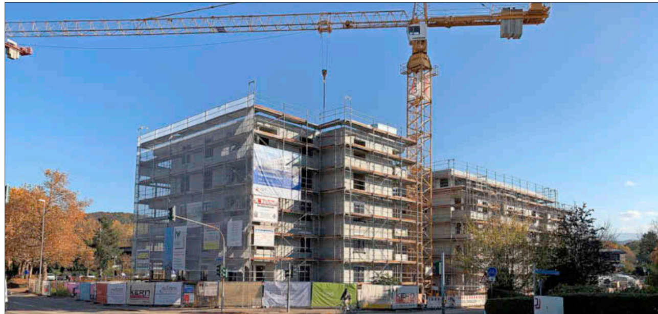
Der Rohbau ist fertig im Haus 1 des Projekts Weinstock-Quartett an der Jahnstraße. Dort entstehen 15 Wohnungen für Mieter mit schmalen Geldbeutel.
